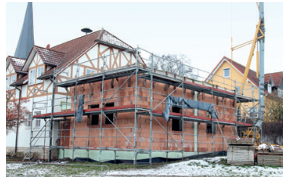
Der im Bau befindliche Erweiterungsbau der Freiwilligen Feuerwehr Alsleben.
