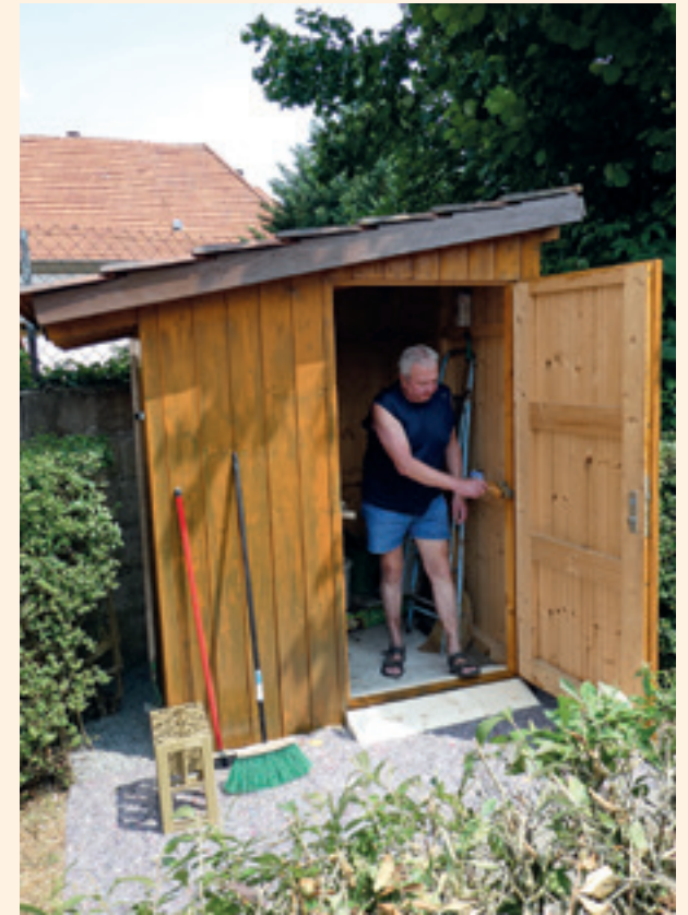
Hans Joachim Seufert bei Renovierungsarbeiten am Gerätehaus im Friedhof.
