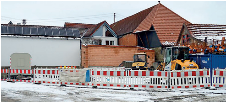
So sah es auf dem Dorfplatz in Trappstadt während der Wintermonate aus. Jetzt sind die Bauarbeiten wieder aufgenommen worden Foto: Alfred Kordwig
