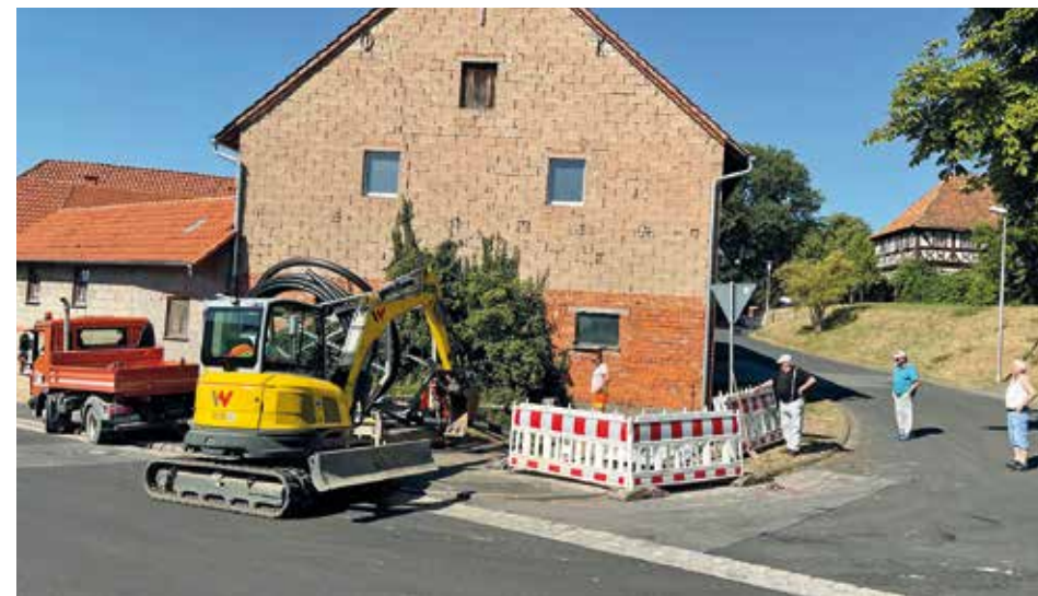
Die Firma Weigand-Bau erstellt die Hausanschlüsse für die Glasfaserleitungen. Somit dürfte in Alsleben das „schnelle Internet“ bald verfügbar sein.
