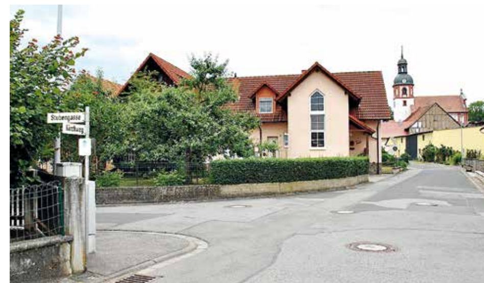
Sanierungsfall Kirchweg und Stubengasse in Trappstadt: Der Kanal muss erneuert werden.
