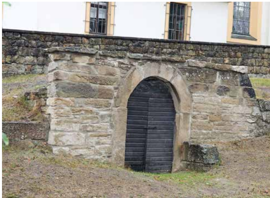
Der Eingang des Gewölbekellers wurde von der Firma Sarkautzky aus der Nachbarschaft Gompertshausen saniert.
