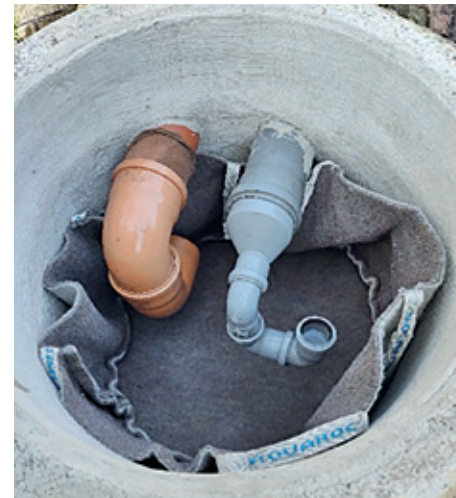
Filter für den Zulauf in die Zisterne: Die Anlage wurden 1994 in Eigenleistung eingerichtet und wird seitdem mit großer Zufriedenheit genutzt. Der Filter wird je nach Verschmutzung oder Starkregenereignisse 2 bis 3 Mal jährlich gereinigt.
