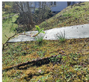
Praxisbeispiel eines in Eigenleistung installierten Gründachs: Für die Konstruktion wurden eine Teichplane, beschwerende Steine und Erde verwendet. Die Begrünung wurde der natürlichen Entwicklung überlassen.
