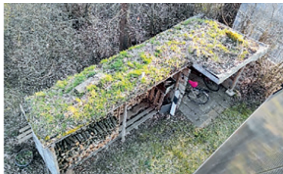
Praxisbeispiel eines in Eigenleistung installierten Gründachs: Für die Konstruktion wurden eine Teichplane, beschwerende Steine und Erde verwendet. Die Begrünung wurde der natürlichen Entwicklung überlassen.
